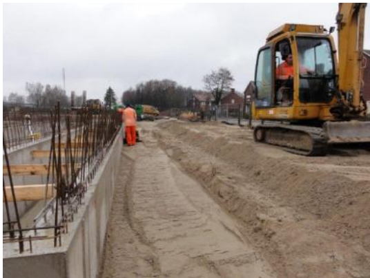
Het eerste grondwerk.
